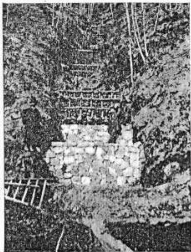
Fig. 5. - Briglie di muratura a secco.
