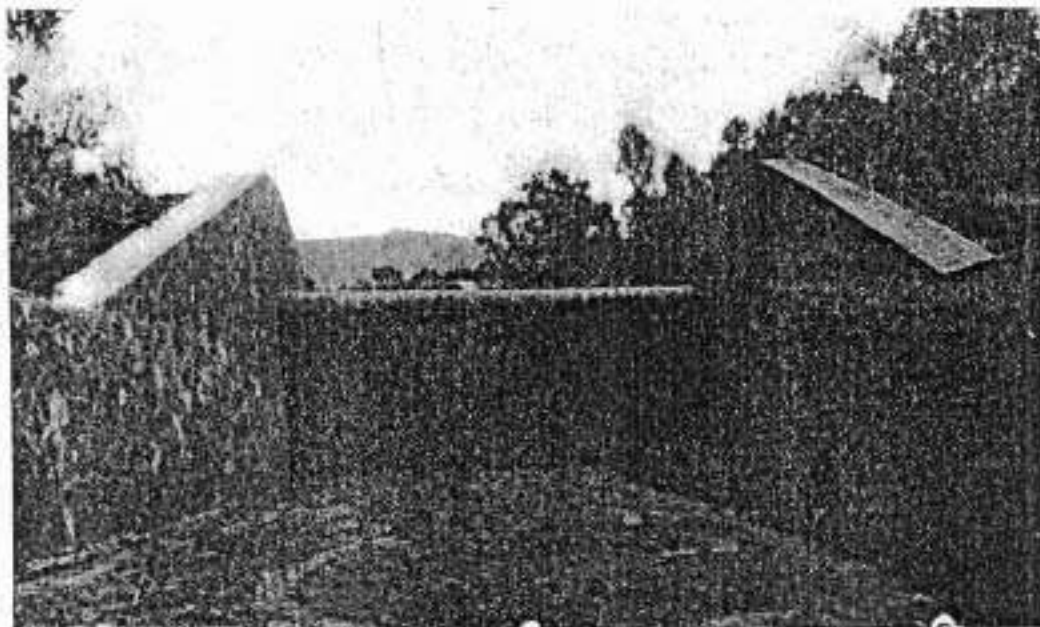
Fig. 7 — Briglia di muratura in malta.
