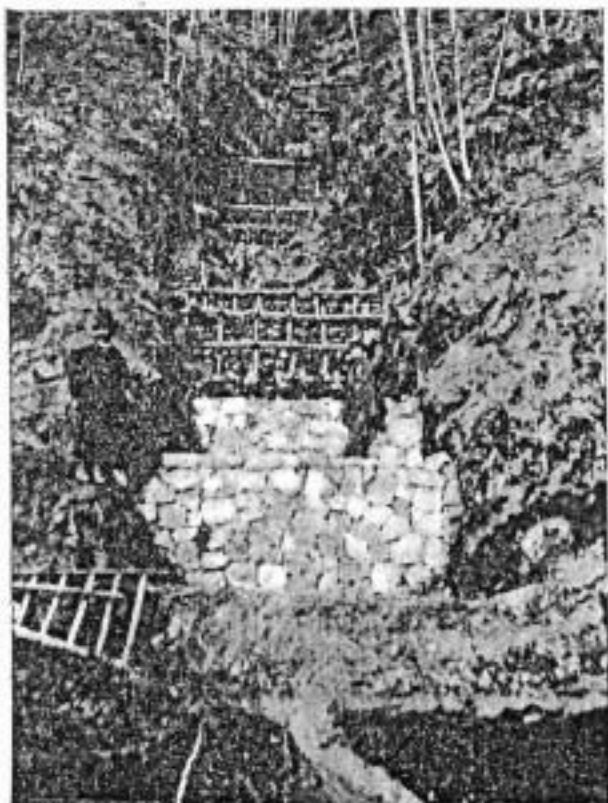
Fig. 5. - Briglie di muratura a secco.
